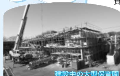
建設中の大型保育園
