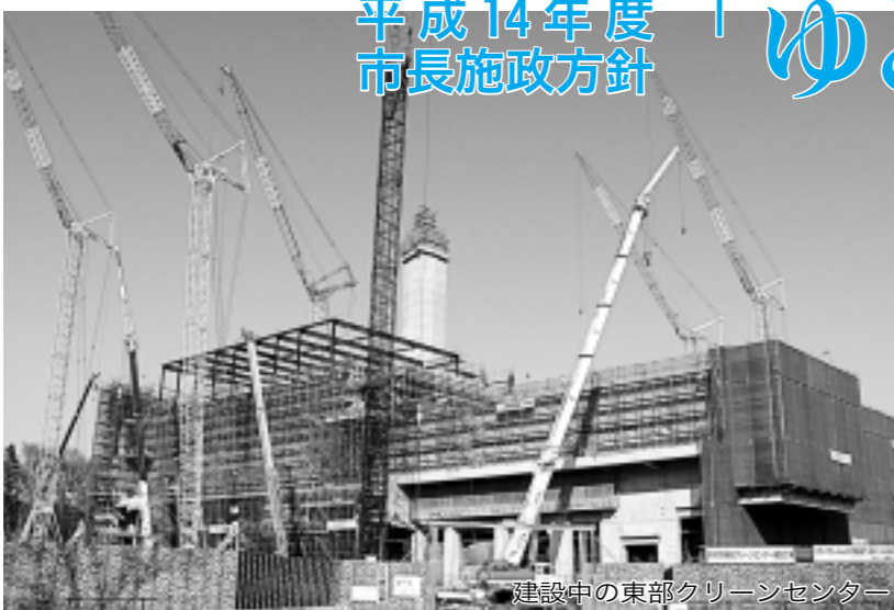
建設中の東部クリーンセンター
