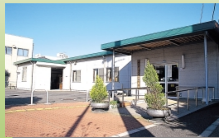
★平成8年にオープンしたリサイクルふれあい館は、粗大ごみの中から再利用可能な物を修理・再生して販売する施設です。広報毎月5日号に掲載の「不用品ガイド」でもおなじみ。◎
