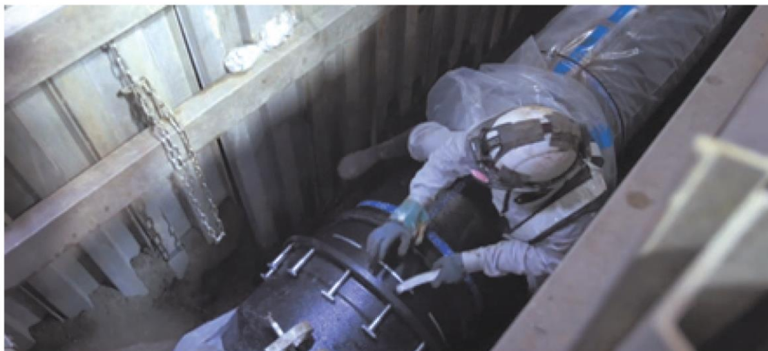
水道管の布設替えの工事の様子
