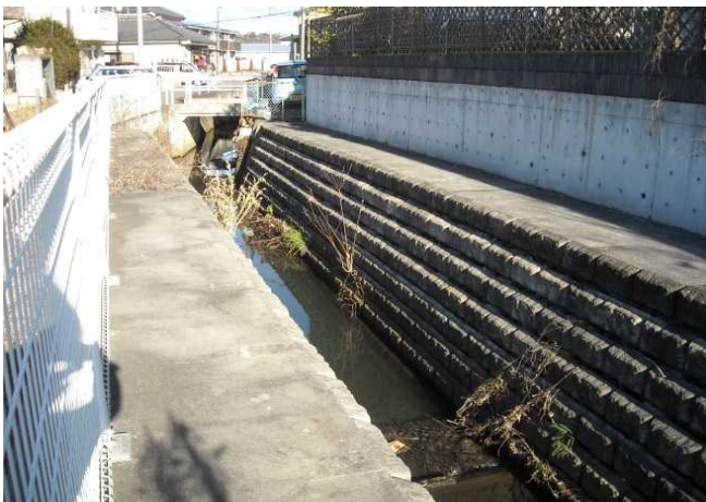
上山口地内水路整備工事
