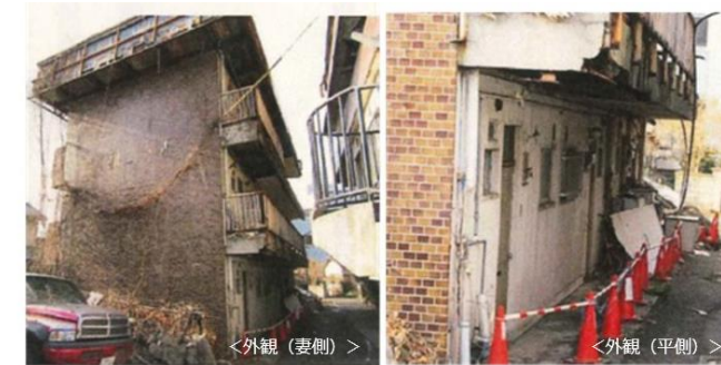
外壁、手すりが崩落した事例
