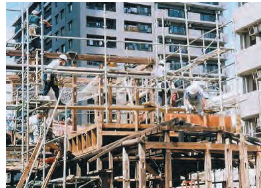
商家の解体保存（灰屋呉服店・元町）
