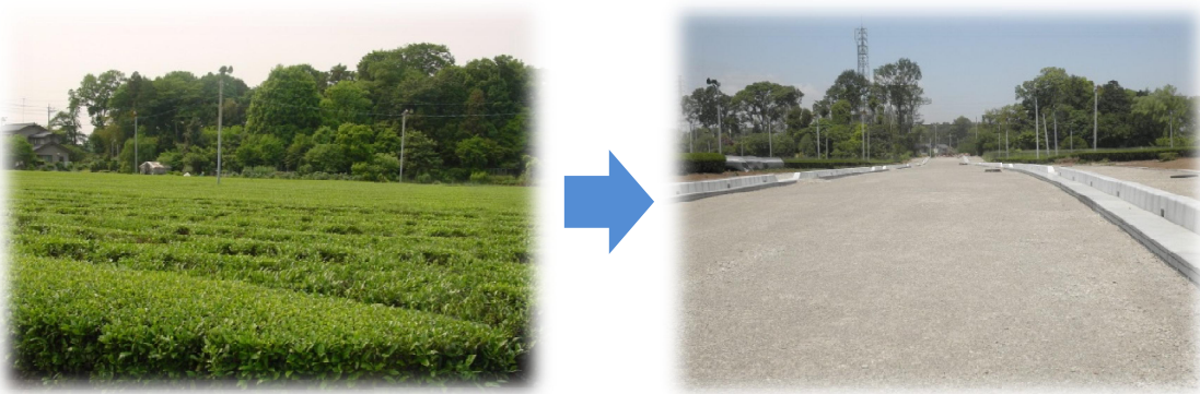
整備が進んだ都市計画道路（左：整備前、右：整備中）
