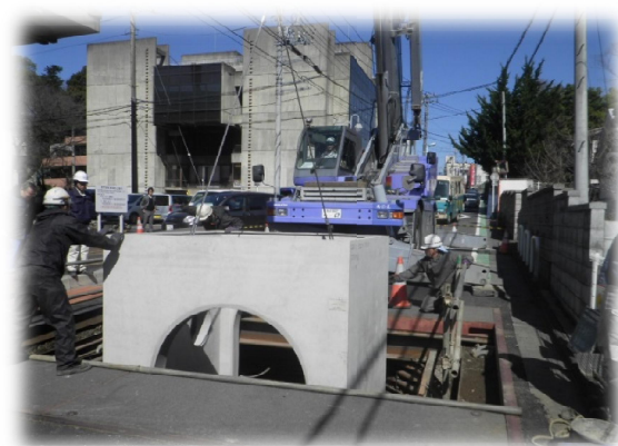
下水道耐震化工事(マンホールの設置状況)
