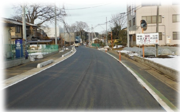
道路改良現場(市道3-3号線)
