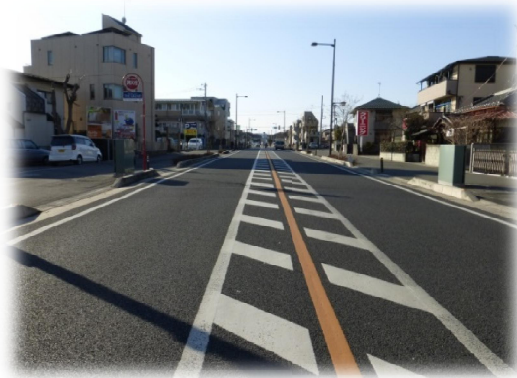
電線地中化(所沢村山線)
