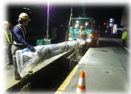
大口径管(400 mm以上)更新工事 (水道管の布設状況)
