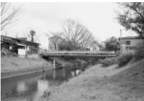
▲集落に掛かる唯一の橋(下安松)
