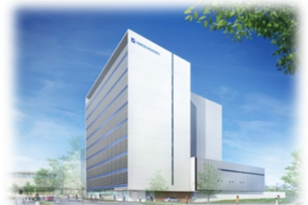
所沢駅東口駅前に建設された 日本光電工業㈱総合技術開発センター
