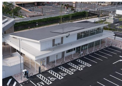
■所沢市観光情報・物産館に設置した太陽光発電設備
