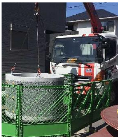
■雨水浸透井築造工事
