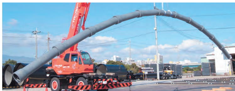
耐震性の高いダクタイル鑄鉄管を吊り下げた画像 (画像提供：日本ダクタイル鉄管協会)
