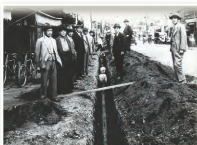
昭和30年の配水管埋設時の様子
