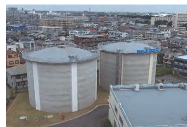
現在の第一浄水場
