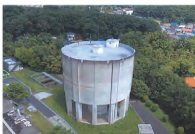
現在の南部浄水場
