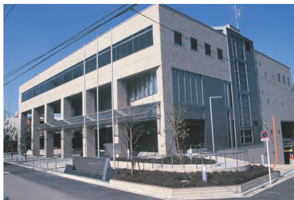
所沢市上下水道局庁舎
