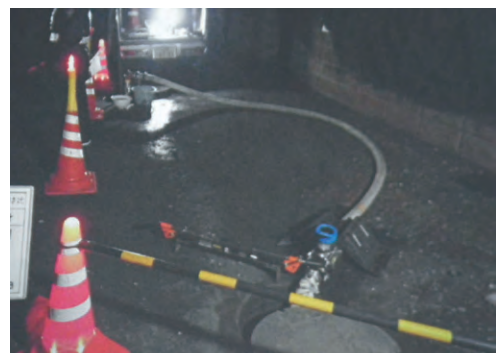
水道管を清掃する夜間作業の様子
