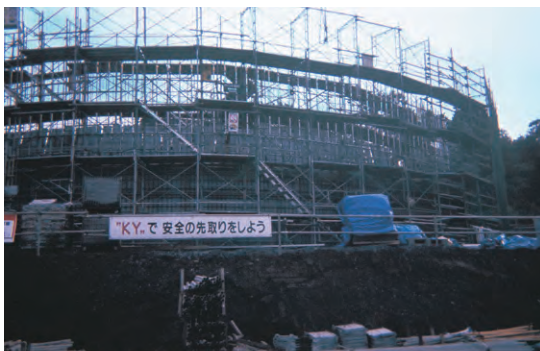
東部浄水場配水池 建設時の様子
