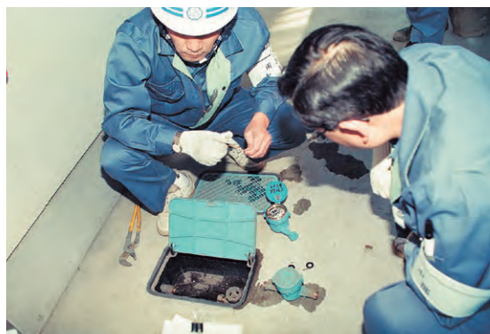
水道メーター点検交換の指導を受ける職員研修の様子
