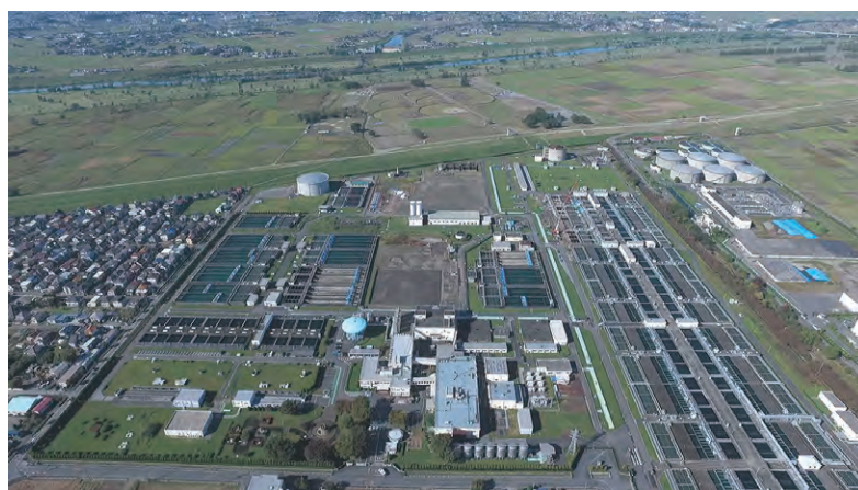
埼玉県大久保浄水場(提供:埼玉県企業局)
