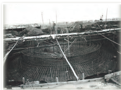
第一浄水場建設時の様子
