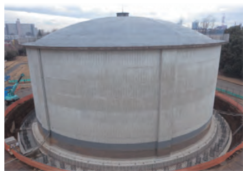
東部浄水場配水池 耐震補強工事の様子
