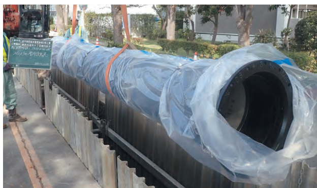
ダクトイル鑄鉄管NS形φ500布設替工事の様子
