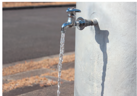
深井戸から汲み上げる地下水
