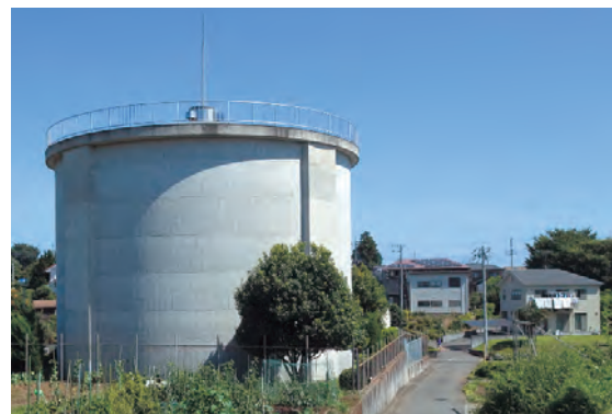
西部加圧ポンプ場
