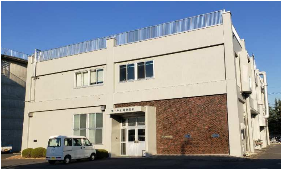
第一浄水場 管理棟
