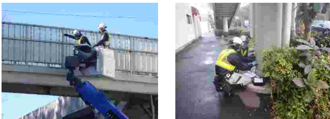
図7 橋梁の定期点検の実施状況
