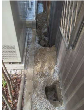
店外部基礎を確認するために掘削した穴
