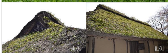
小野家住宅 (修理前外観)
